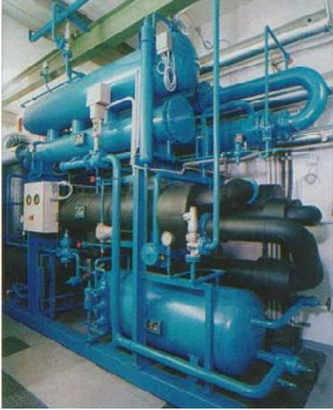
Verdichter: ABB Stal-Astra Refrigeration
