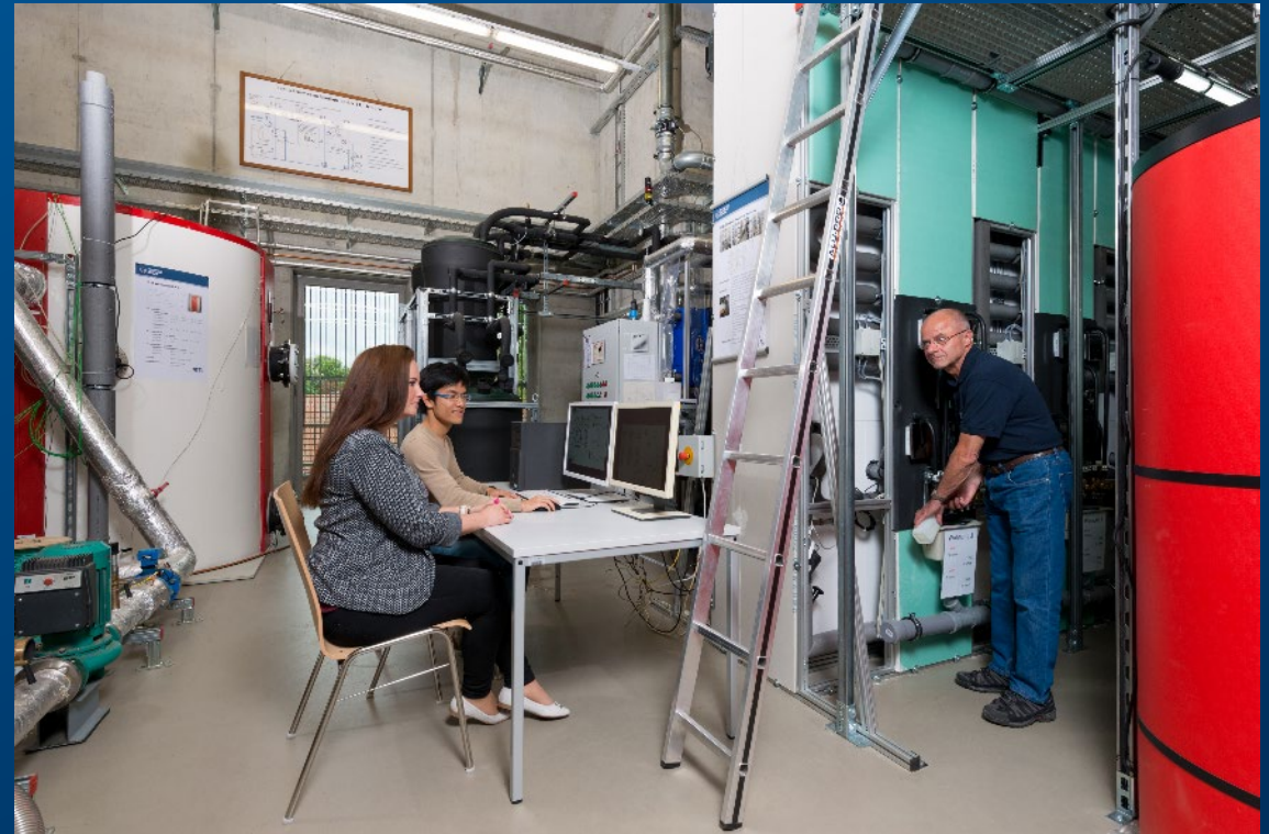
Zentrum für Energietechnik der TU Dresden Versuchsfeld Rationelle Energieanwendung/Regenerative Energien mit TWI-Versuchstand – Emulation Mehrfamilienhaus 6 WE
