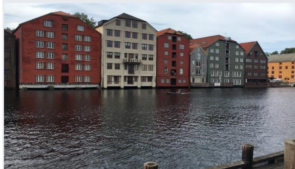
Alte Warenhäuser in Trondheim, Norwegen
