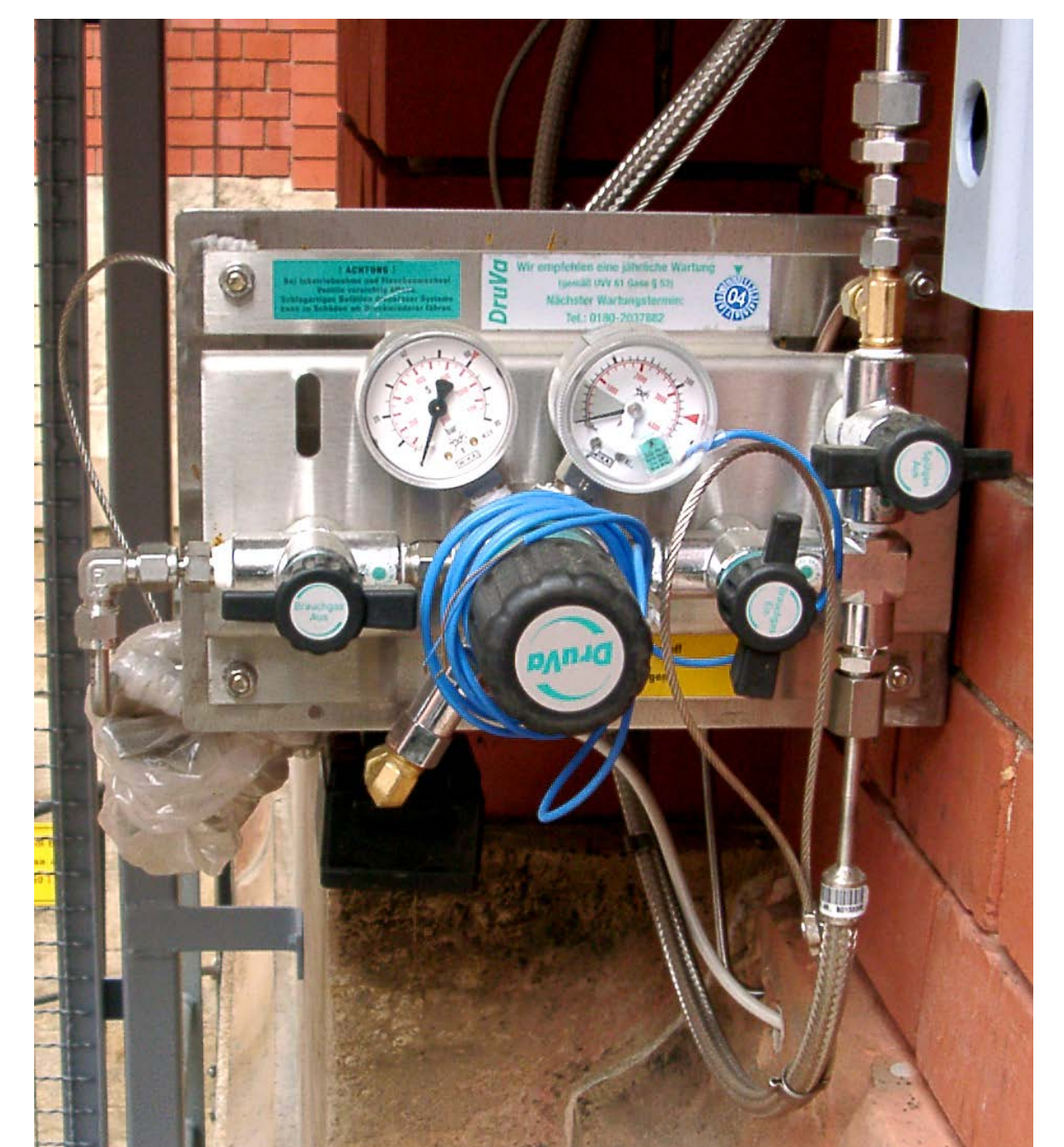
Wasserstoff-Vorratsbereich mit Armaturen
