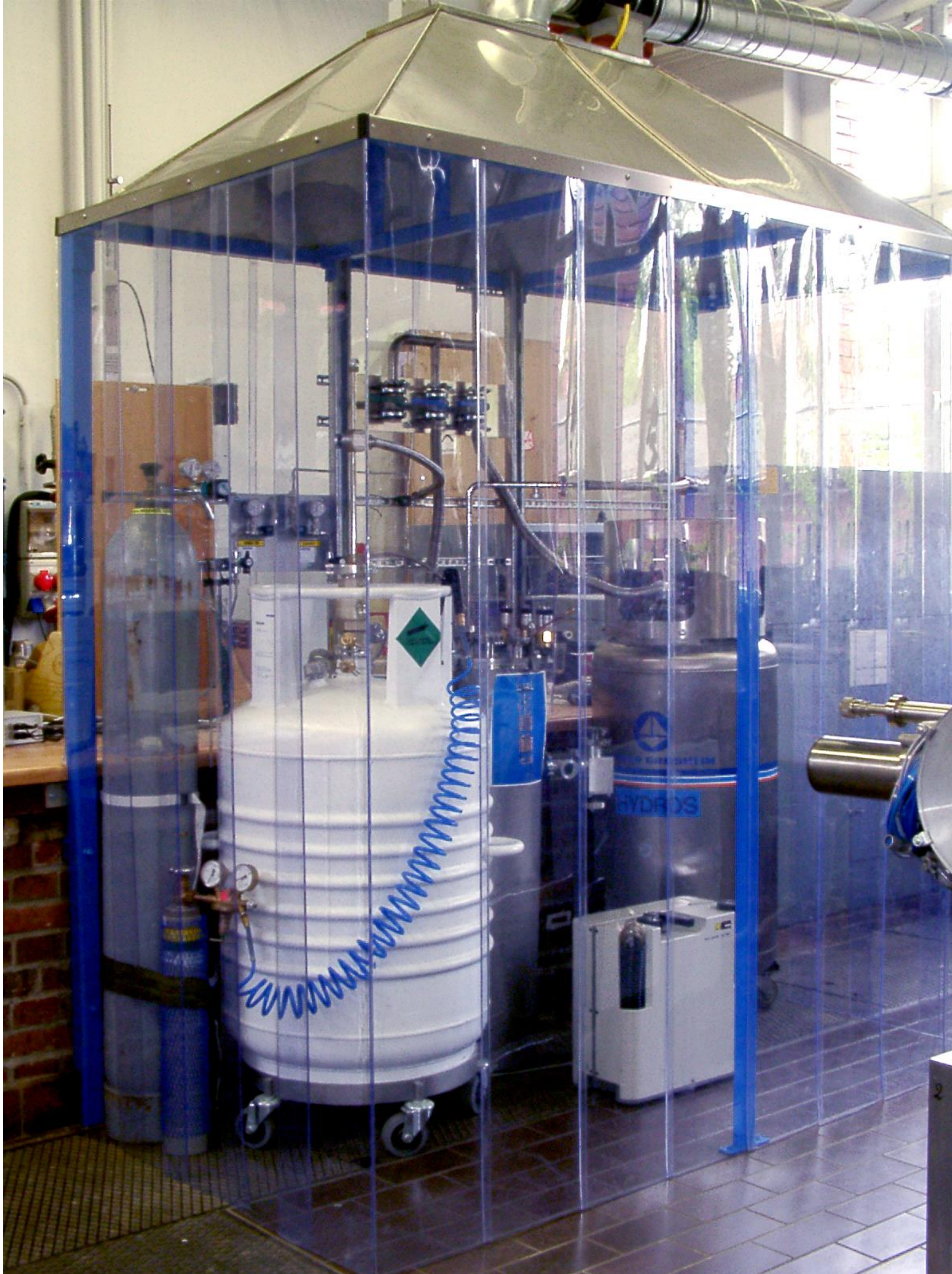
Schutzzone mit Abzugshaube und Lamellenvorhang
