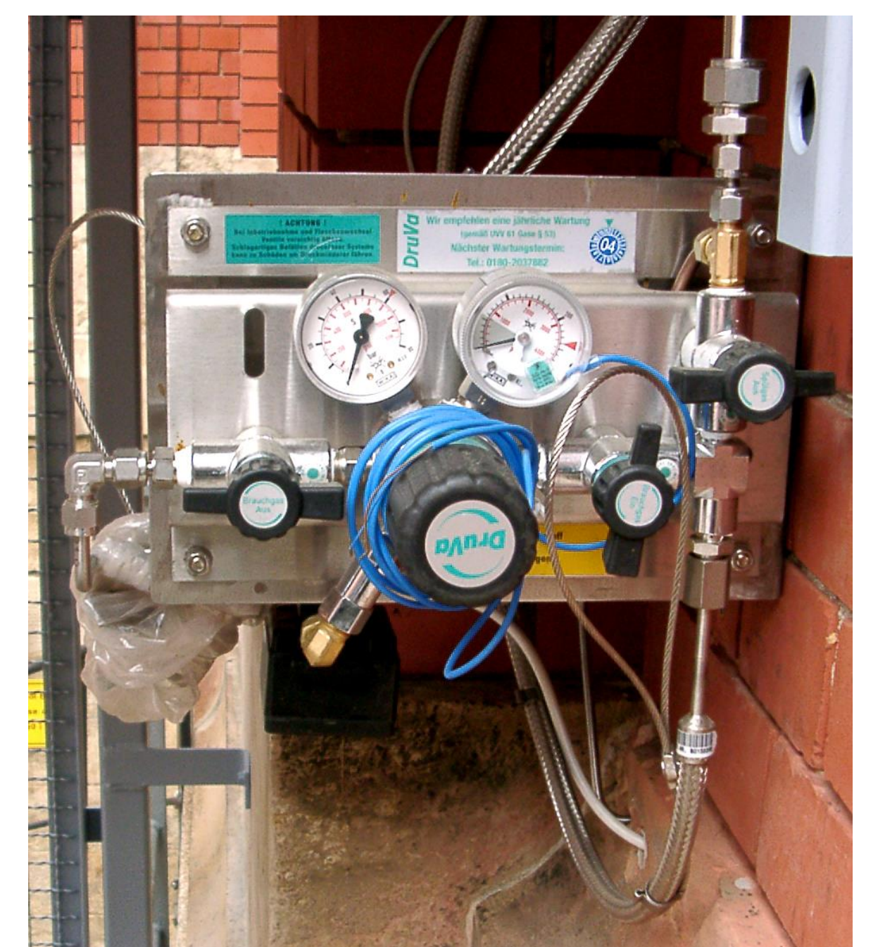
Wasserstoff-Vorratsbereich mit Armaturen
