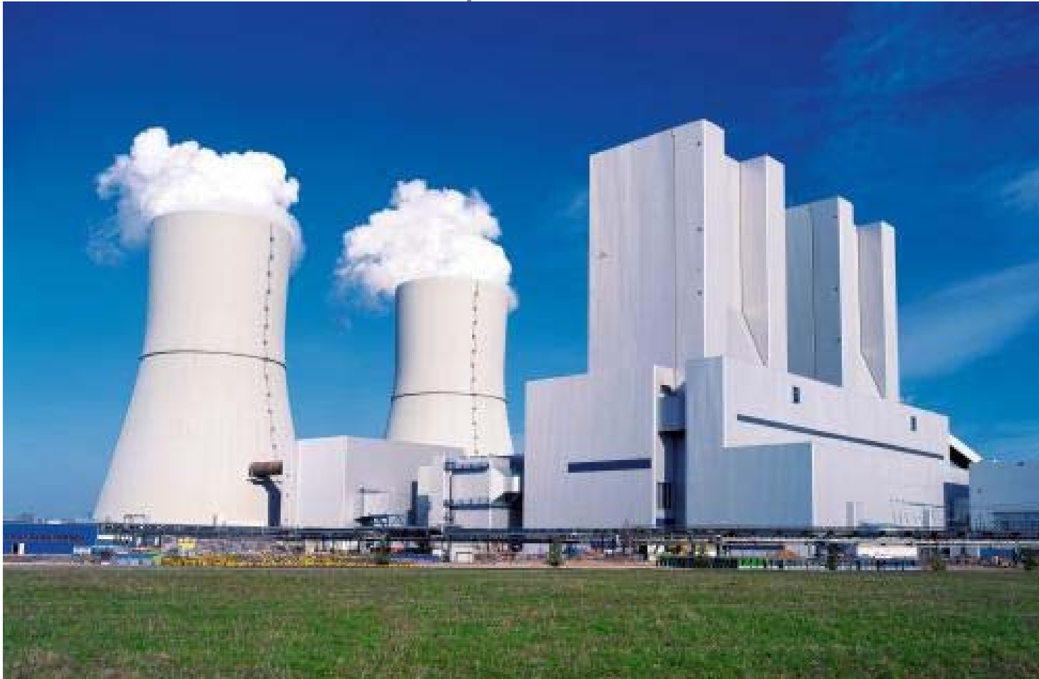
Kraftwerk Schwarze Pumpe
