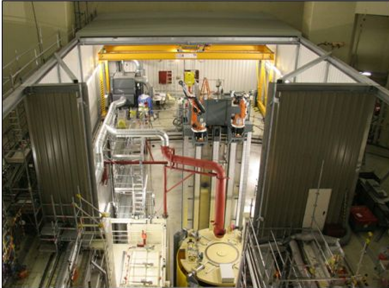
Fernhantierter Rückbau Stade
