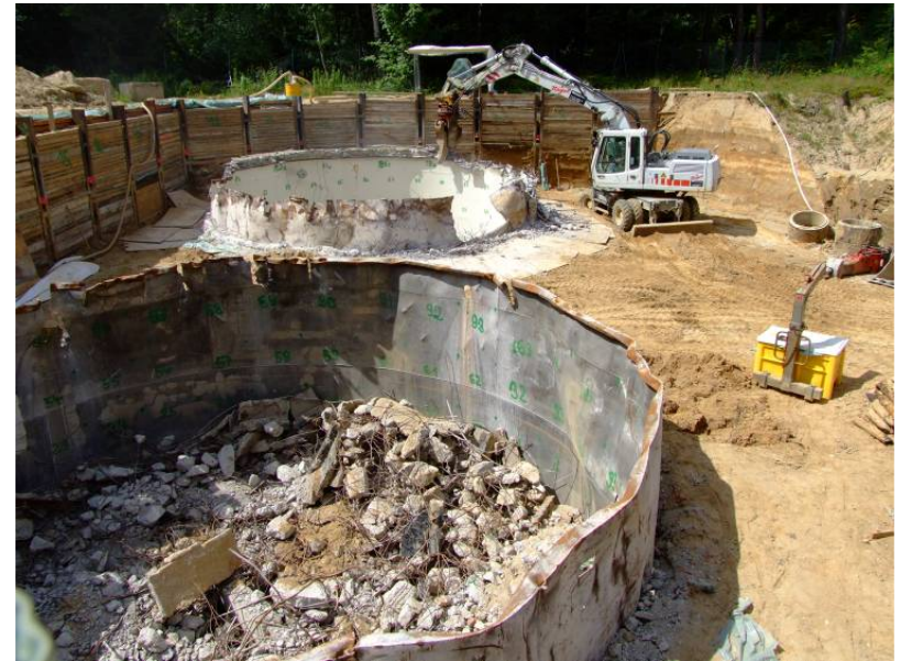
Rückbau der Reaktorabwasserbehälter
