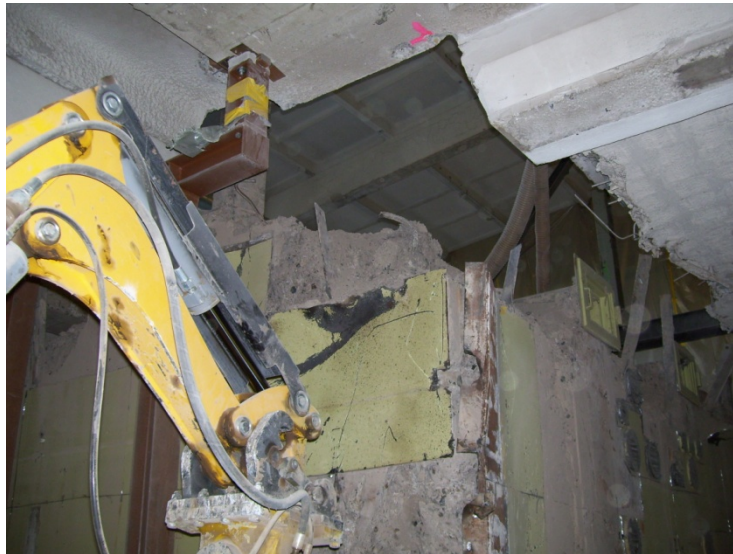
Rückbau der „Heißen Zellen“
