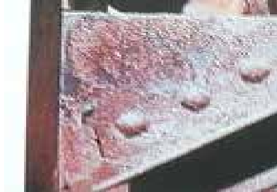
Flächenkorrosion
