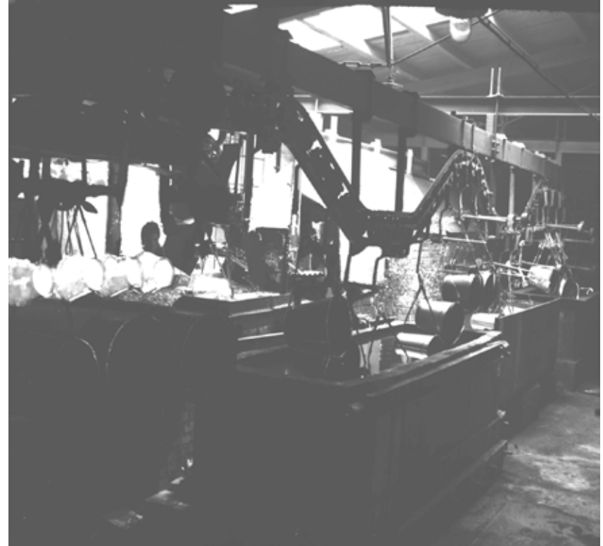
Kontinuierliche feuZn-Anlage für Stückgut 1951
