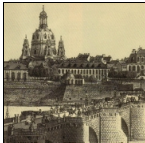
Bild 11: Pavillon auf der BRÜHLSchen Terrasse in Dresden – erstes Unterrichtsg Gebäude der Technischen Bildungsanstalt [9]
