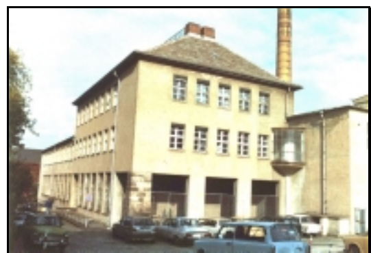
Bild 72: (Lehr-) Gebäude Heizkraftwerk Aufnahme etwa 1985
