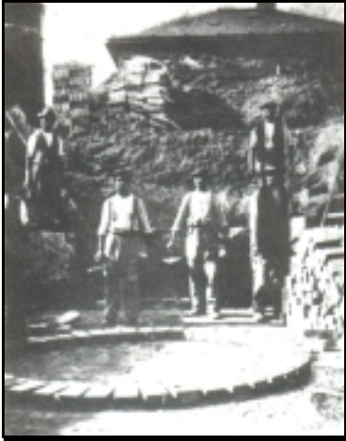
Bild 48: Grundsteinlegung (Baubeginn) des 45 Meter hohen Schornsteins des Fernheiz- und Elektrizitätswerkes 1900 [10, 18]
