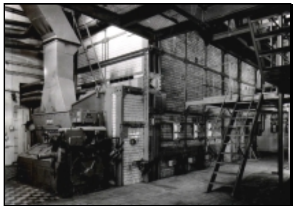
Bild 55: Fernheiz- und Elektrizitätswerk Zwangsumlaufkessel, Bauart La Mont (Kessel 1)
