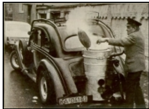
Bild 59: Ein mit Holz und Torf betriebener Adler-Diplomat (1936)
