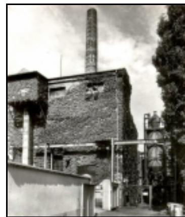
Bild 51: Das Heizkraftwerk der Technischen Hochschule, Ansicht etwa 1960
