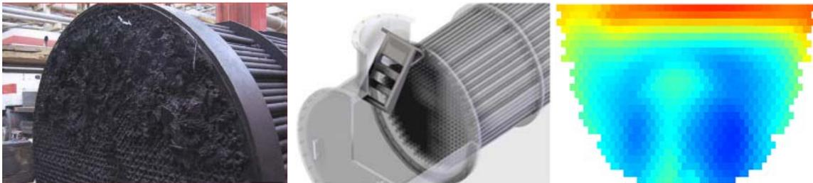
Ein Grund für die Ablagerungsbildung ist die ungleichmäßige Anströmung des Rohrbündels. Im Rahmen des FlowEnhancer-Projekts soll ein Einbau entwickelt werden, welcher zu einer gleichmäßigen Anströmung des gesamten Rohrbündels führt.
