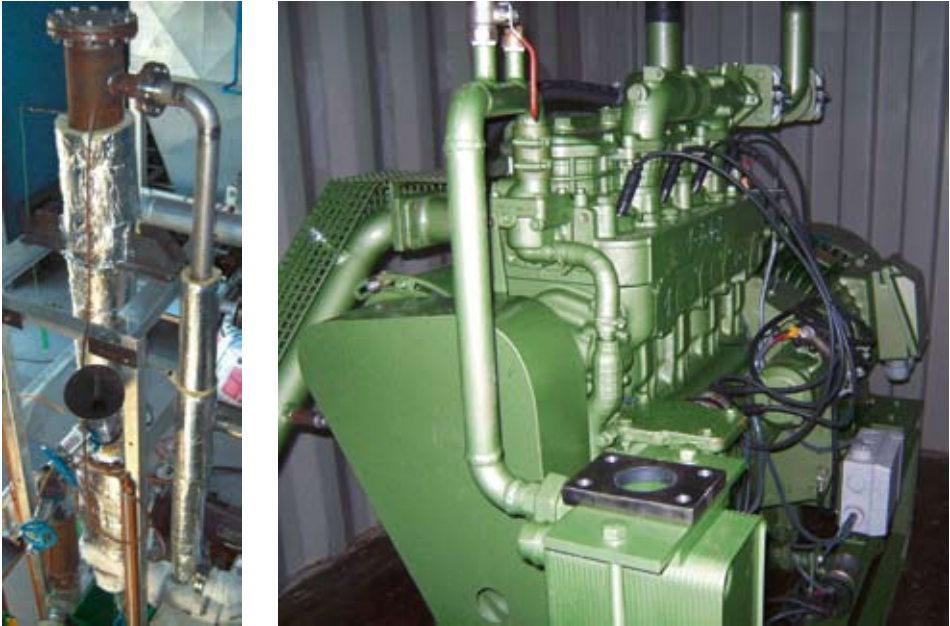
Bild 2: Wirbelschichtkühler und Blockheizkraftwerk der Versuchsanlage zur Gleichstrom-Festbettvergasung im Institut für Energietechnik der TU Dresden
