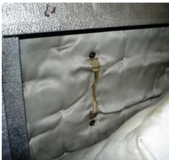
Abb. 8. Isolierte Membranwand, Segmentöffnung zur Wärmestromdichtemessung, AVA Augsburg.
