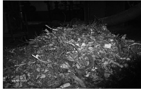
Abbildung 3. Störstoffe in der Wirbelschicht im Steinkohlekraftwerk Flensburg [20].
