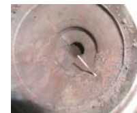
Rohrleitung nach Gasaufbereitung
