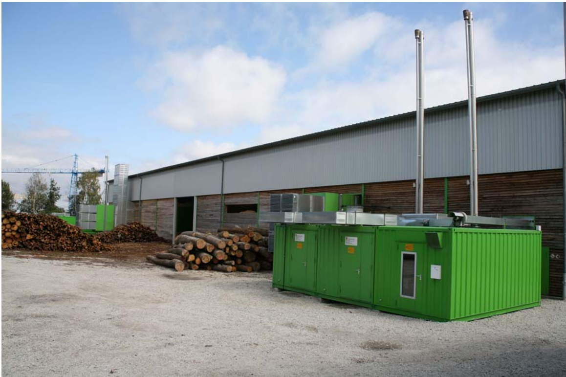
Abbildung 29: Referenzanlage HEH Holzenergie Hunsrück, Pfalzfeld 4 x 250 kW el , Darstellung bereitgestellt vom Hersteller
