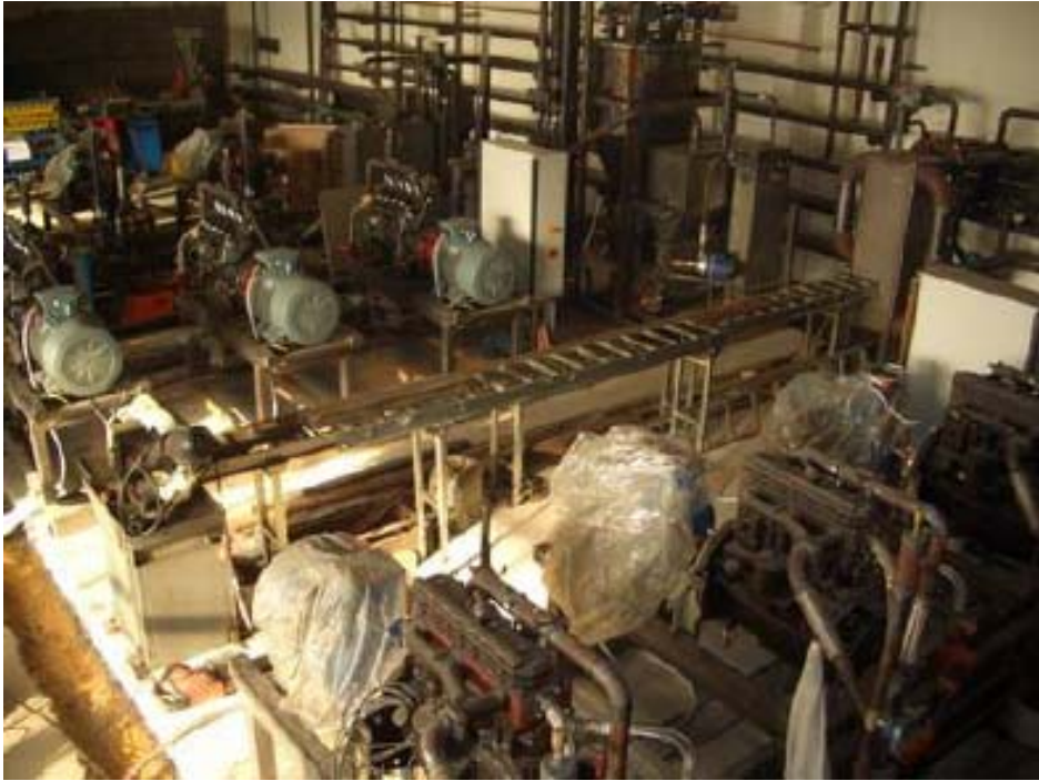
Abbildung 25: Eine aus drei Modulen bestehende Anlage mit 270 kW el während der Montage Ende Dezember 2008, Quelle: Vortrag von Herrn Baumann auf der CEP Stuttgart 2009
