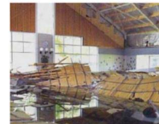
Kollaps einer Dachkonstruktion eines Schwimmbads aufgrund Verwendung nicht ausreichend korrosionsbeständiger Schrauben
