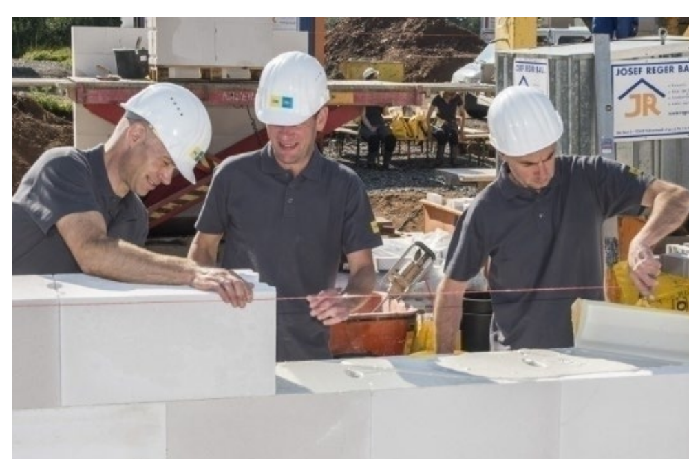
Manuelle Erstellung von Mauerwerk
