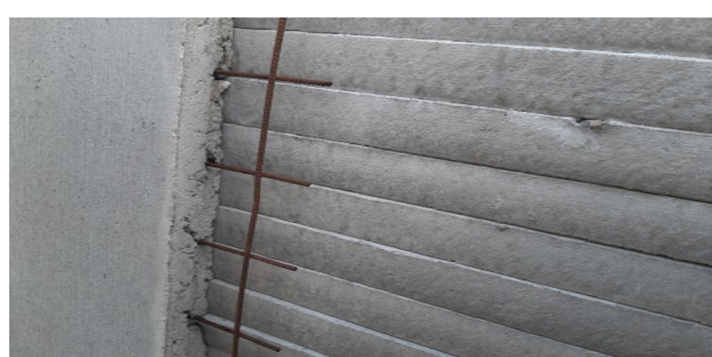
Beispiel für Stahlbetonwand aus additiver Fertigung
