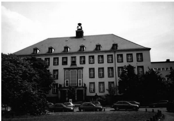
Abb. VI-8: Gebäude am Weberplatz, Hauptsitz des Lehrstuhles Holz- und Faserwerkstofftechnik bis 1995
