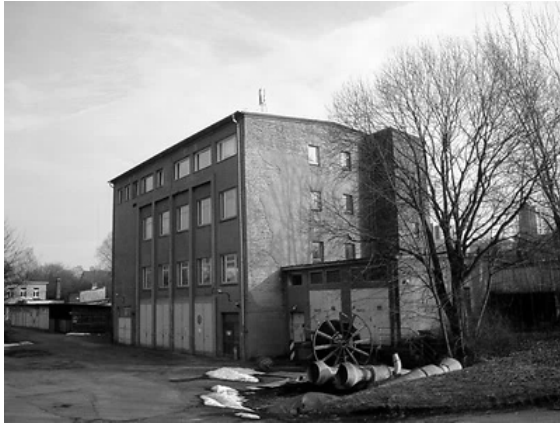
Abb. VI-7: Objekt Zellescher Weg („Sog. Heizhaus“)
