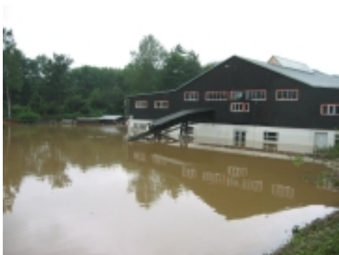
Das Hauptgebäude mit den Werkstätten Während der Überflutung durch die Weißeritz
