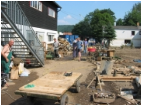
Aufräumungsarbeiten durch Mitarbeiter, Studenten und andere Helfer nach dem Rückgang des Hochwassers
