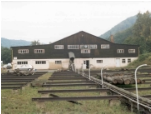
Das Holztechnikum in Freital/ Hainsberg vor dem Hochwassereinbruch
