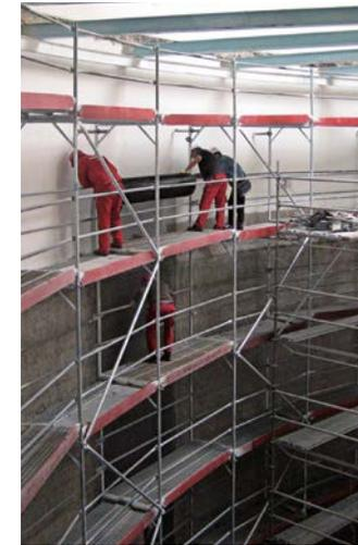
Innere Oberfläche sowie Zwischendecke des Stahlbeton-Bauwerks waren großflächig gerissen. TUDALIT® ermöglichte die Stabilisierung bei vergleichsweise geringem Eigengewicht – bei vier textilen Bewehrungsschichten wurde der Feinbeton nur insgesamt zwei Zentimeter dick aufgetragen. Ein Stahlbeton-auftrag wäre, schon allein wegen der
