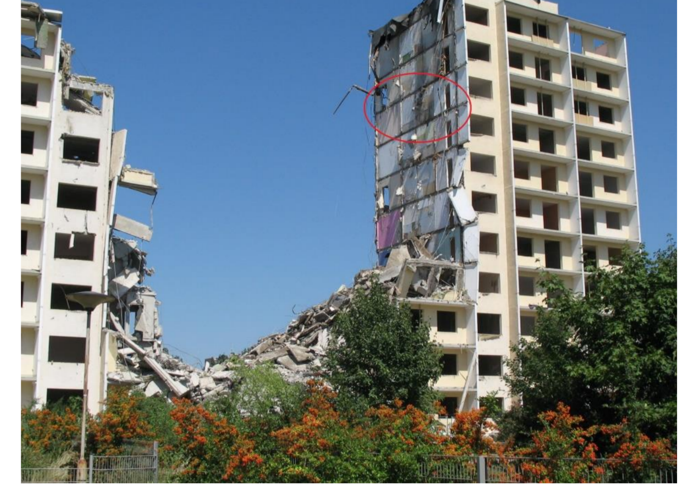
Abriss Wohnhaus, Wohnkomplex VIII
