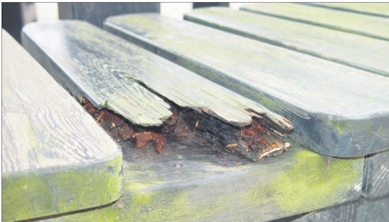
Der Zahn der Zeit hat kräftig an der runden Bank Mommsenstraße/Ecke Helmholtzstraße genagt. Sie sieht mittlerweile nicht nur schlecht aus, sondern birgt auch Gefahren durch das splitternde Holz. Wer schafft hier Ordnung? Foto: UJ/Eckold
