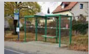
Fahrgastunterstand, Bushaltestelle in Meißen – Bauernhausl – Projektmaßnahme Förderprojekt [2]
