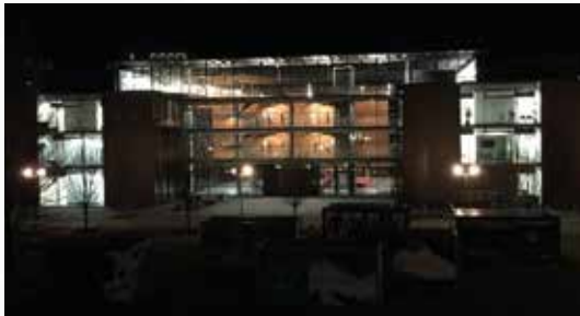
Bei Nacht beleuchtetes Biologie-Gebäude und Lüftungsklappen auf der Nord- und Südseite des Biologie-Gebäudes [7].
