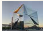
Bürogebäude „Cube Berlin“ [8]
