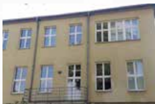
Ostseite des Cotta-Baus: deutlich ist die Spiegelung der Rosskastanie zu sehen [7].
