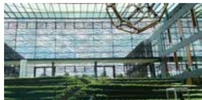
Biologie-Gebäude der TU Dresden, Innenansicht Südseite, Muster „Organische Struktur“ [1], (1: 6%, 2: 20%, 3: 15%, 4: 13%, 5: 16%, 6: 19%, 7: 10%).
