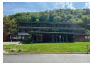
Westseite des Judeich-Baus mit durch Automatik geschlossenen Jalousien [7].
