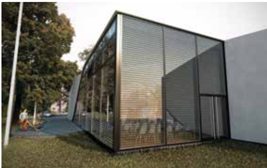
CUBE TU Dresden, Ansicht der Rückseite [1]
