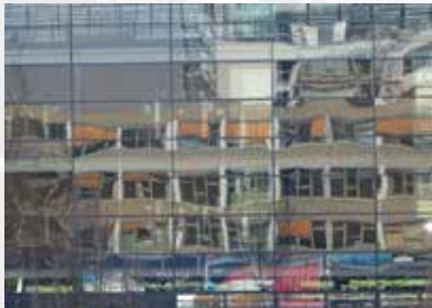
Das Biologie-Gebäude mit seinen ausgeprägten Glasfassaden [1]
