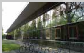
Rechenzentrum Bundesamt für Steuern und Finanzen
