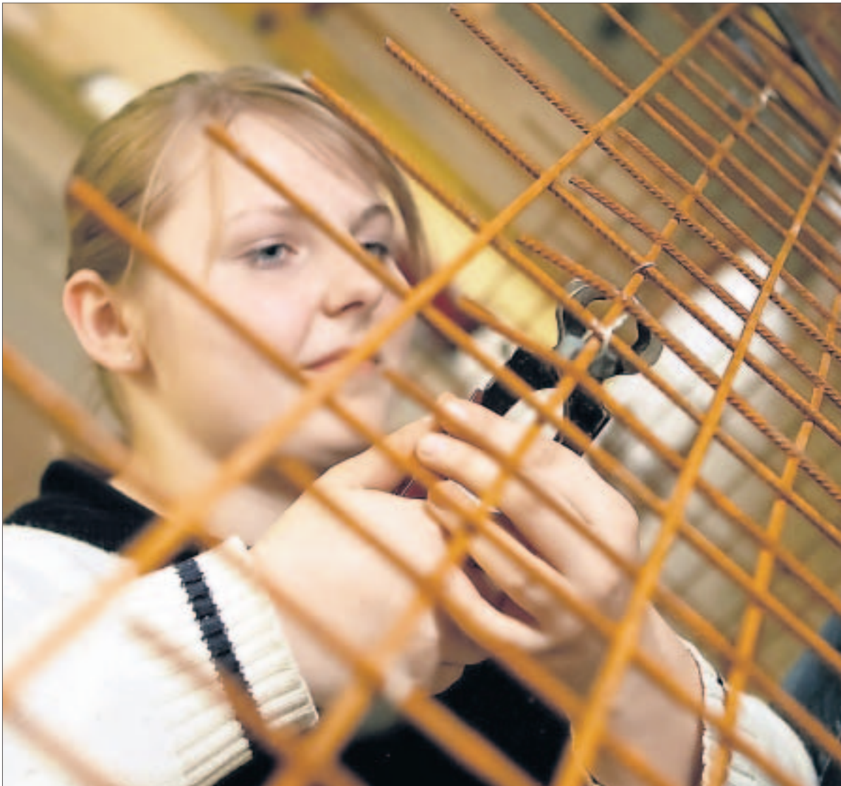
Andrea Quaß bereitet die Bewehrung für die Bootssegmente vor. Dafür haben die Studenten in Tschechien Stahlmatten besorgt. Immer zwei werden mit Draht miteinander verbunden.
