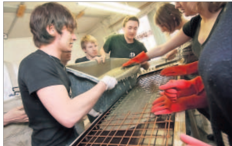
Das ganze Team ist notwendig, wenn der frische Beton in die Holzform gegossen wird.
