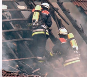
Durchbruchgefahr! Unsicherer Stand auf angebrannten Dachlatten
