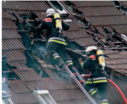
Schon besser: Die Steckleiter als Last verteilende Unterlage auf der Dachfläche
