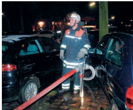
Der PKW stand über dem Unterflurhydranten – in diesem Fall musste das Hindernis weggerückt werden.
