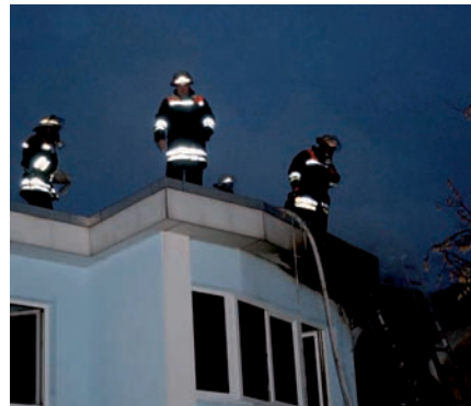
Absturzgefahr an der Kante des Flachdaches
