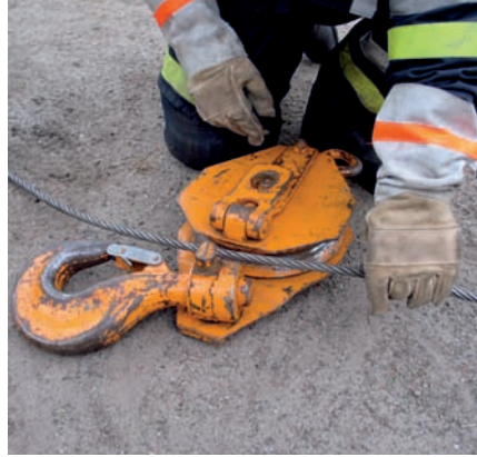
Einlegen des Drahtseiles in die Rolle
