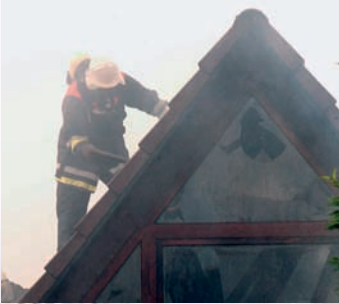
Absturzgefahr! Brandbekämpfung auf dem Steildach
