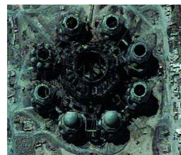
📷 Bau einer Moschee in Bagdad, Satellitenbildaufnahme
