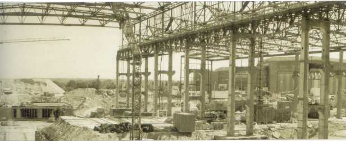
Stahlskelett nach der Entkernung (ehemaliger Hangar)
