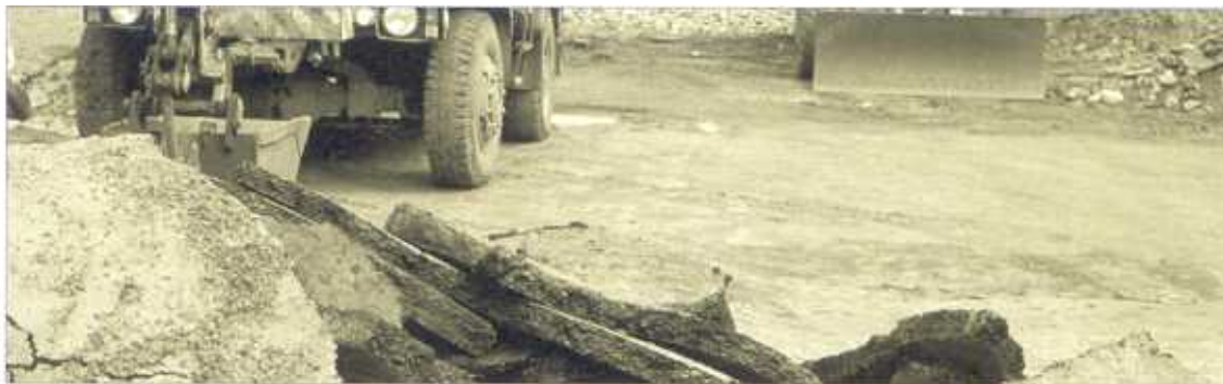
Millionen von Mark werden im Jahr auf die Wartung sächsischer Straßen verwendet
