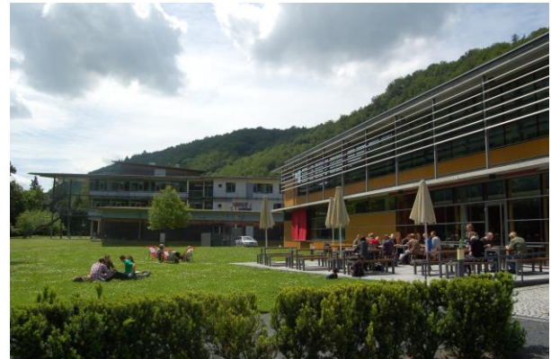
Bild 22: Lehrgebäude und Mensa in Tharandt
