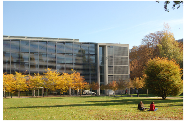
Foto 1: Hörsaalzentrum der TU Dresden auf dem Campus in der Südvorstadt
