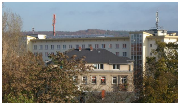
Foto 4: Gebäude der Medizinischen Fakultät mit Solarstromanlage
