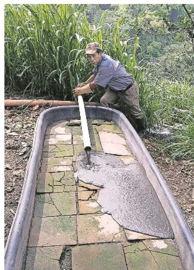
In Guatemala wird in einem Projekt der Abwasserschlämme getrocknet, um ihn dann zu entsorgen oder weiterzuverarbeiten. Foto: UNU-FLORES
