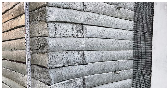
Aus den gedruckten Betonbahnen entstehen Wände. Foto: TUD
