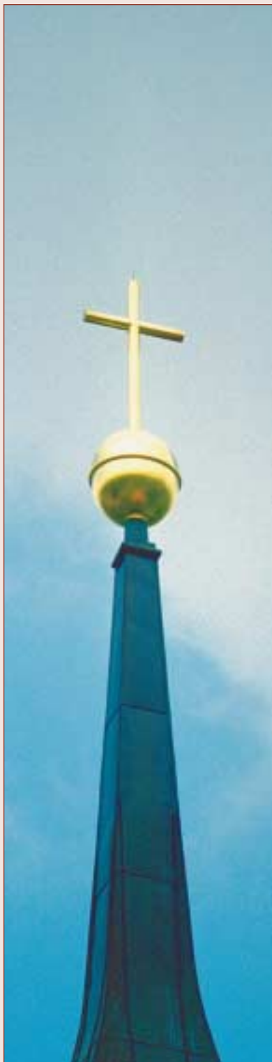
Der Knopf an der Turmspitze der Dresdner Annenkirche (erbaut 1764–69) ist keine Kugel, sondern ein Ellipsoid.
