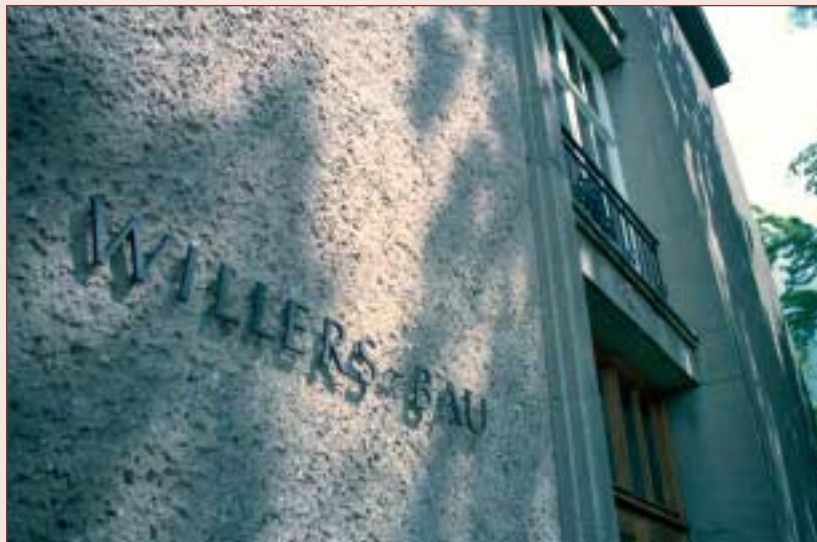
Willers-Bau. Das großzügige Gebäude für die Dresdner Mathematik entstand nach Willers' Vorstellungen und unter seiner Aufsicht. Es trägt heute seinen Namen.
