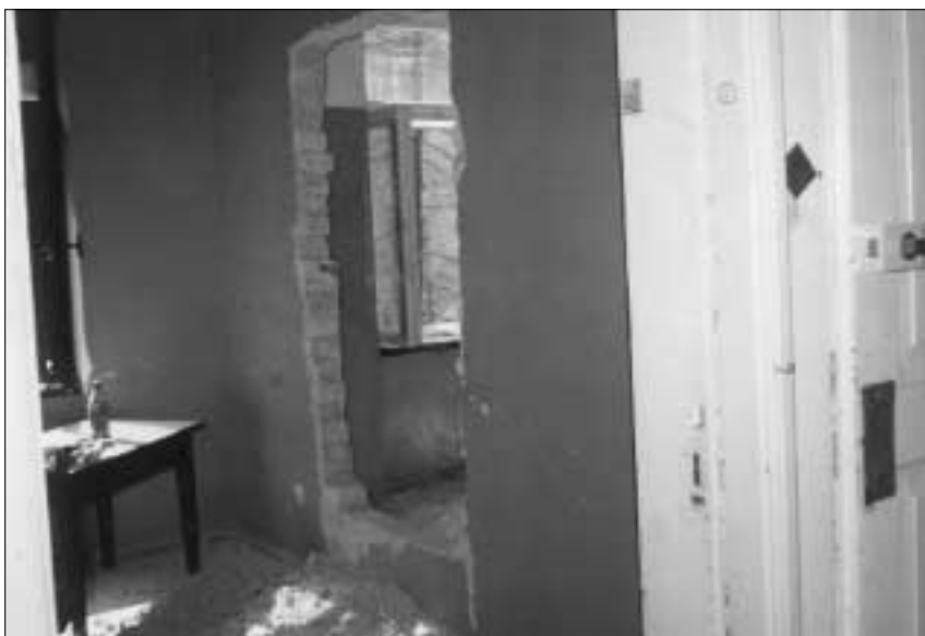
Den Durchbruch schaffen – auch in der Altbausanierung
