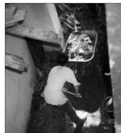
Eva im Keller bei der Schuttbeseitigung.
