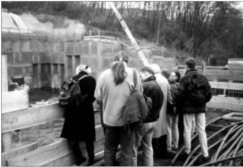
Besichtigung der Baustelle für das Parkhaus am Domplatz. Fotos: Autoren
