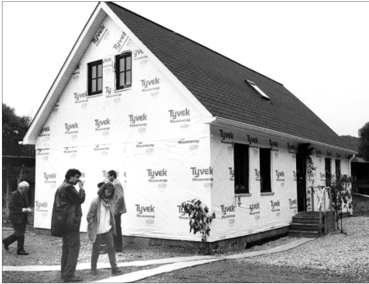
Ökohaus der TUD in Freital-Hainsberg: Forschung für ökologisches Bauen und Wohnen. Unser Foto entstand im vergangenen Jahr kurz vor der Fertigstellung. Foto: UJ/Eckold
