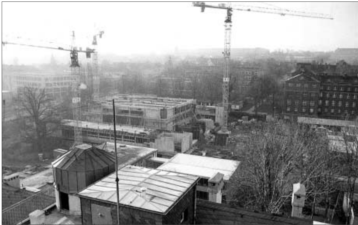
Mit den ersten Frühlingstagen rückt der Baufortschritt beim neuen Hörsaalzentrum der TU Dresden wieder mehr in den Blickpunkt Neugieriger. Schon im Oktober 1998 sollen dort die ersten Vorlesungen gehalten werden. Foto: UJ/Eckold
