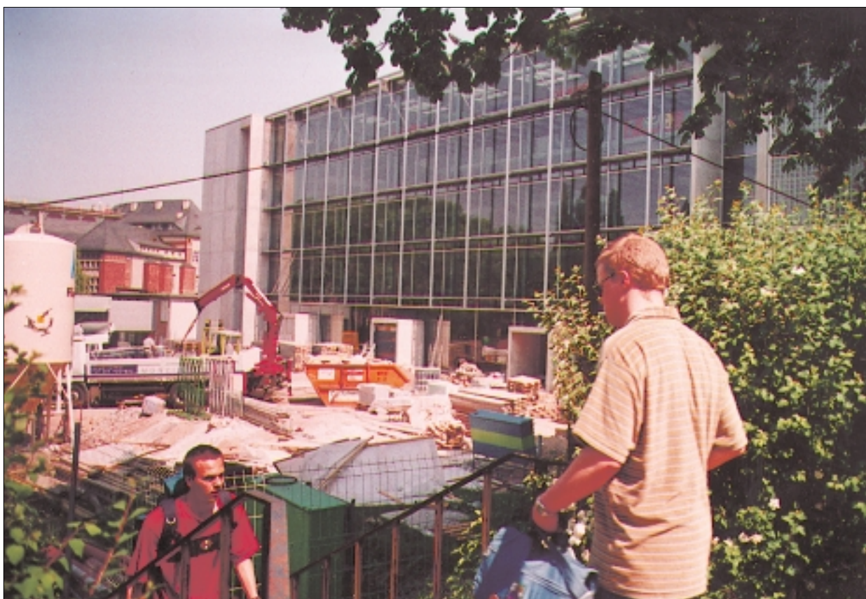
Mit großen Schritten geht die Fertigstellung des neuen Hörsaalzentrums an der Bergstraße voran. Gegenwärtig wird von einer Vielzahl von Firmen die technische Gebäudeausstattung wie Elektro, Heizung, Lüftung und Sanitär installiert. Die langersehnte feierliche Übergabe wird am 13. Oktober erfolgen. Bereits im September werden die ersten Nutzer ihre neue Wirkungsstätte beziehen. Foto: UJ/Eckold
