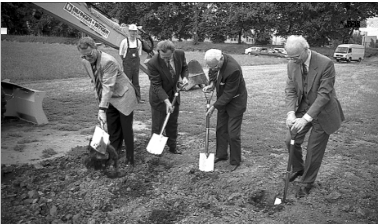
Am 13. Juli 1998 begann der Bau des 180 Millionen Mark teuren Bibliotheksgebäudes am Zelleschen Weg. Im Jahr 2001 wird die neue Sächsische Landesbibliothek - Staats- und Universitätsbibliothek auf 13 000 Quadratmetern überbauter Fläche 4,2 Millionen Bestandseinheiten, 920 Leseplätze und 284 Mitarbeiter beherbergen. Beim ersten Spatenstich: Wissenschaftsminister Hans Joachim Meyer, Staatssekretär Karl-Heinz Karl, TU-Prorektor Hans Wiesmeth und Bibliotheks-Generaldirektor Jürgen Hering (v.r.n.l.). Foto: UJ/Eckold
