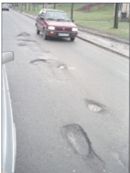
Loch an Loch und hält doch? Dresdens Straßen... Foto: UJ/Eckold
