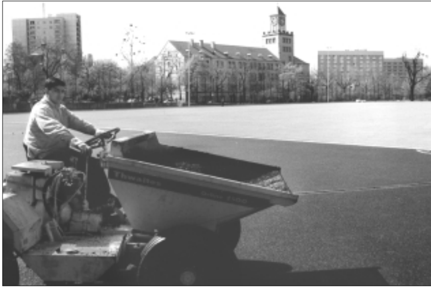
Ali Özdemir von der Firma Özdemir Sportbodensysteme (Herford) arbeitet am Kunststoffbelag auf dem Sportplatz August-Bebel-Straße. Ende Mai soll die Anlage übergeben werden. Foto: Venetianer
