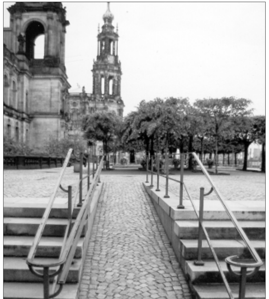
Die vorher nur durch Stufen ausgeglichene Höhendifferenz auf der Brühlschen Terrasse kann mit der nachträglich eingebauten Rampe auch durch Rollstuhlfahrer bewältigt werden. Foto: Archiv Pfeil
