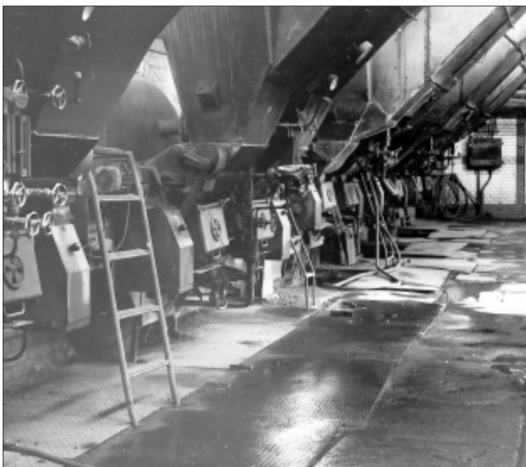
Ein Blick in das Kesselhaus des Heizkraftwerks mit automatischer Kohlebeschickung. Fotos: Mauersberger
