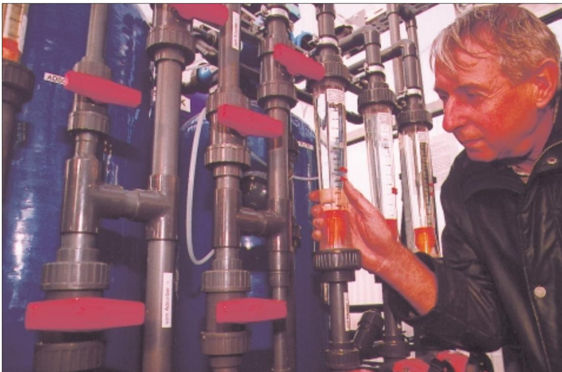
VW errichtete für den Botanischen Garten eine Wasseraufbereitungsanlage für etwa 170 000 Mark. „Stündlich strömen etwa 50 Liter Zisternenwasser durch die Rohre, bei einem Druck von fünf Bar werden Fremdstoffe herausgefiltert und der pH-Wert wird auf 6,5 heruntergedrückt“, erklärt Dietmar Gneuß, verantwortlicher Meister für die Gewächshäuser.
