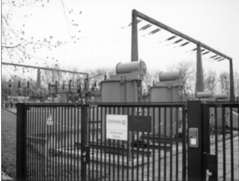
Umspannwerke – wie hier das in Dresden-Räcknitz – müssen regelmäßig auf Herz und Nieren geprüft werden. Die Firma Theta nimmt solche Untersuchungen mit einer Infrarotkamera vor. Der Clou: Durch spezielle Berechnungen kann die jeweilige Restnutzungsdauer der Anlage berechnet werden.
