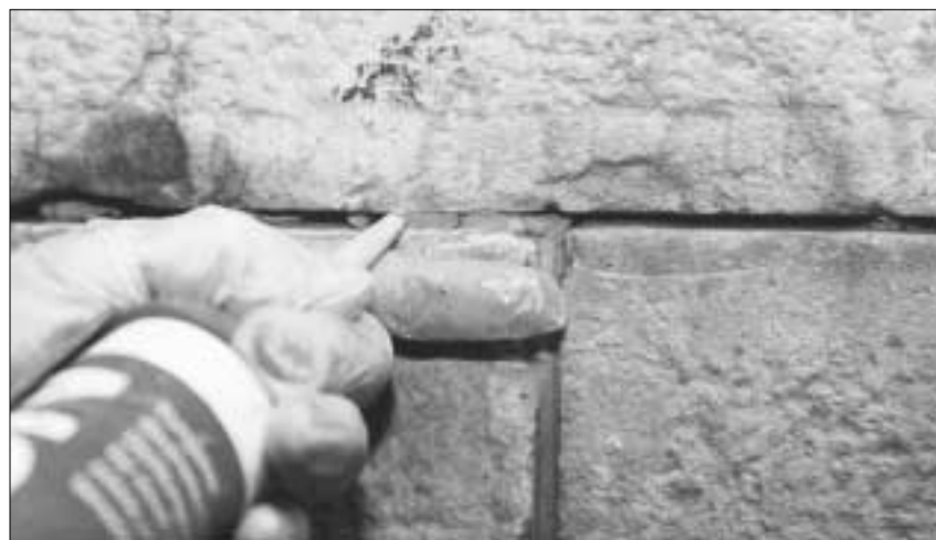
Mit einer neuen Verfügunstechnologie und dazugehörigem Mörtel gelingt es nun, Sandsteinfassaden besser zu sanieren. Foto: Professur für Baustoffe
