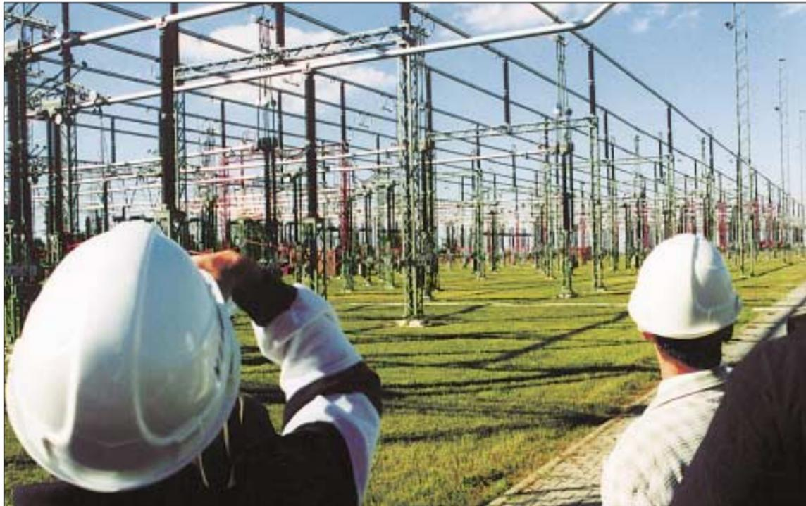
Im Umspannwerk Bad Lauchstädt: Man sieht hier die Stromschienen, die bei den Spannungen im Kilovolt-Bereich etwas größer dimensioniert sein müssen. Ein ständiges Summen lag in der Luft. Foto: Konrad Seidel
