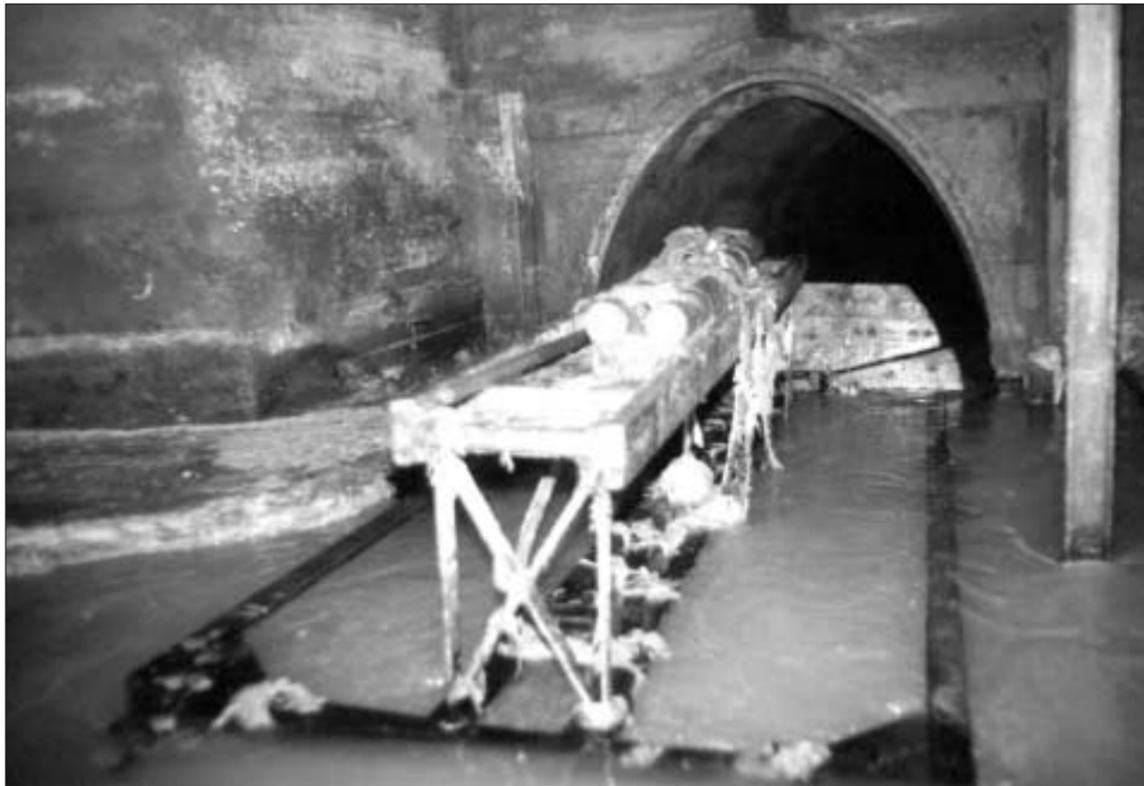
Kanalbetriebsarbeiter haben einen Stauwagen in den Dresden-Altstädter Abfangsammler eingebracht. Mit ihm wird die Sohle des Abwasserkanals gereinigt. Foto:TUD/ISI
